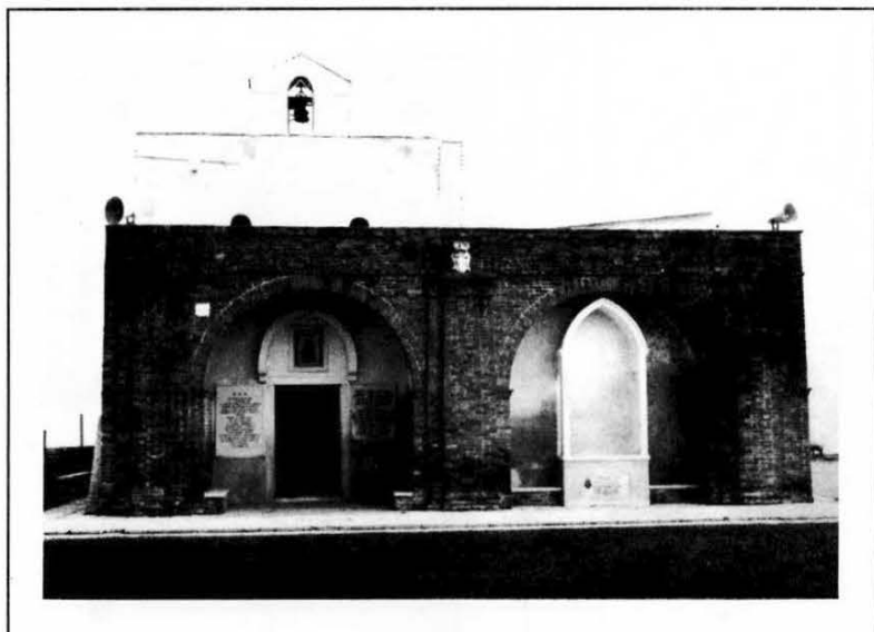
4 - Santuario prospetto principale ad ovest
