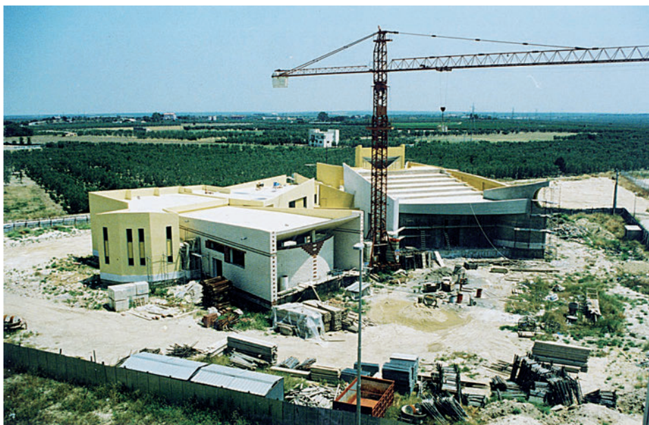
1995. Lavori di costruzione della chiesa
