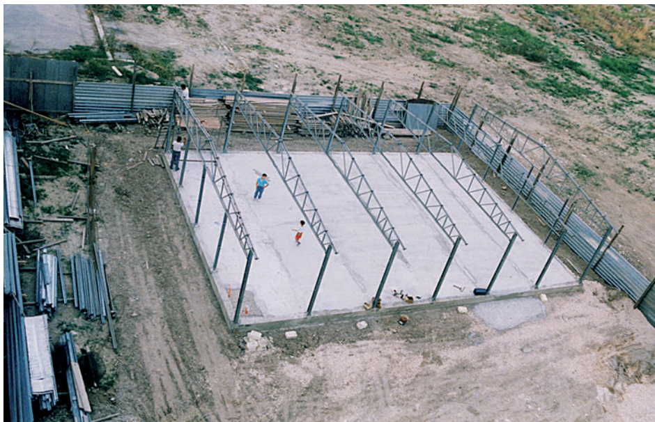
1991. Impianto del prefabbricato donato dalla Diocesi di Sant'Angelo dei Lombardi
