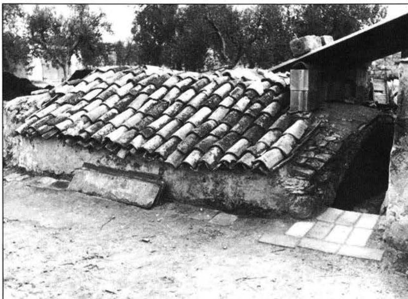
37 - Tettoia di copertura e ingresso della rampa di accesso alla camera di combustione della fornace di Potito Ferraro, in contrada Fornaci (territorio di Cerignola).
