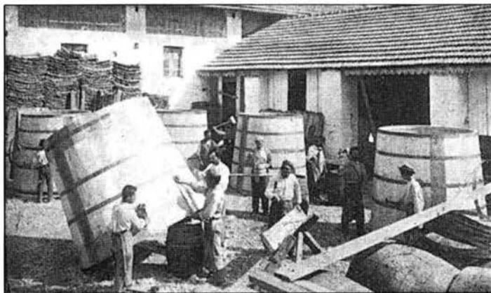
31 - Inizi '900, stabilimento san Domenico, di Pavoncelli, in Cerignola. Bottai al lavoro nel cantiere per la costruzione del bottame necessario alla produzione vinicola della Casa.
