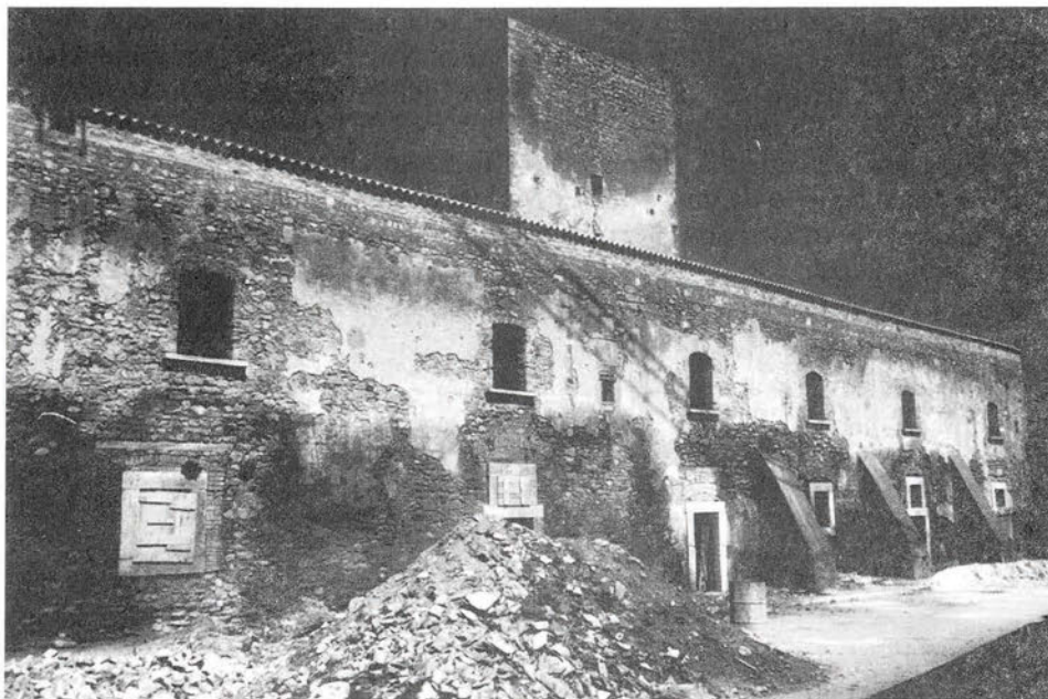
Prospetto sud del palazzo dell'Abate
