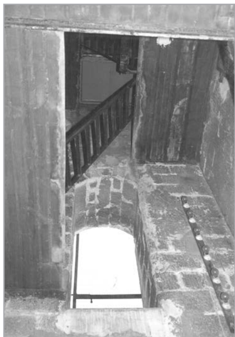
Interno del campanile
