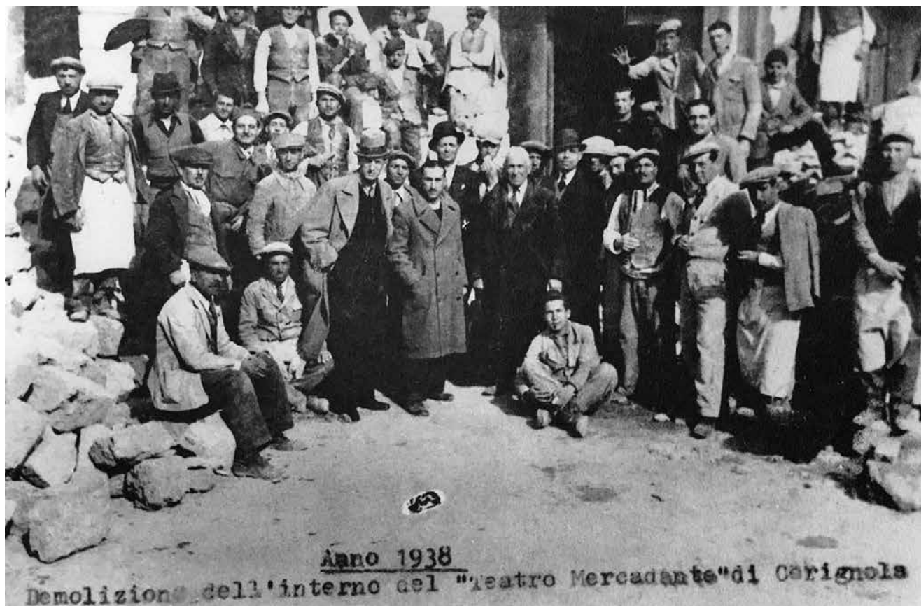
L'impresa Antonio Pedone durante i lavori di ristrutturazione del teatro (collezione famiglia Reitani).
