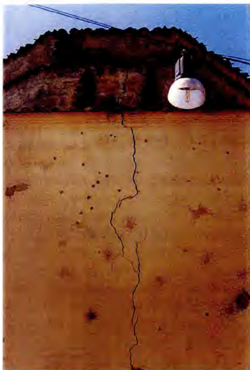
Fessurazione passante nel muro perimetrale della navata destra
