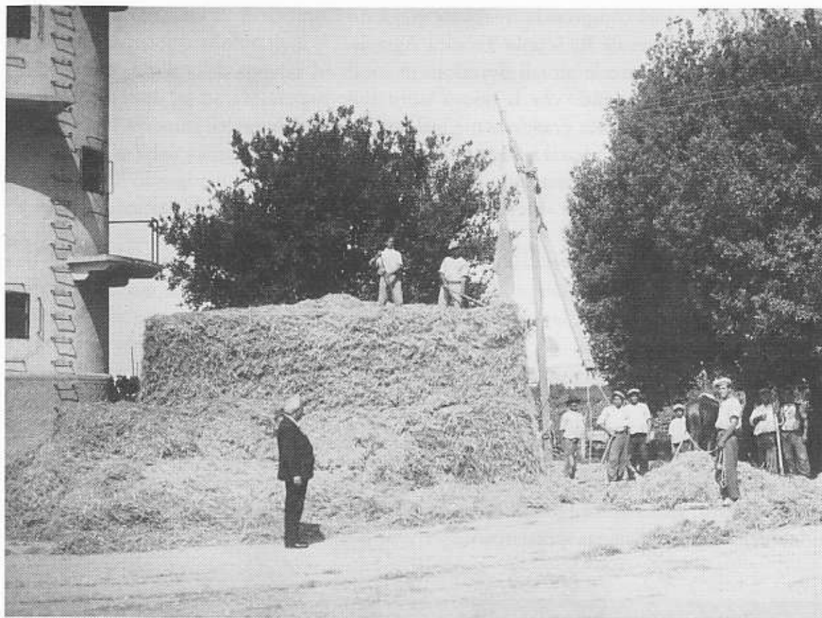
Dopo il 1936. Regia Scuola Tecnica Agraria. Esercitazioni di costruzione di un pagliaio.
