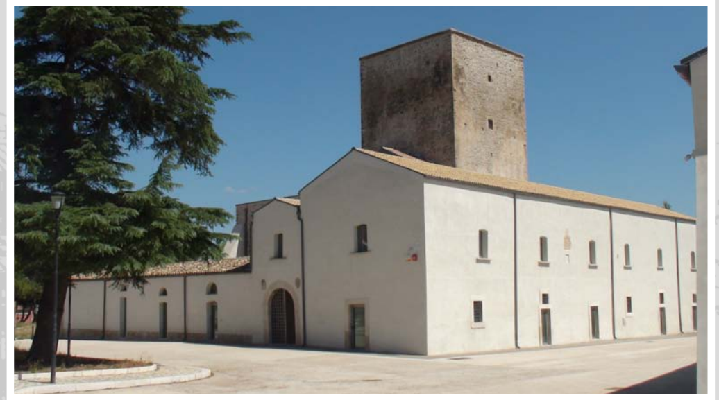
veduta da sud-ovest del complesso masseriale (foto V. Russo)
