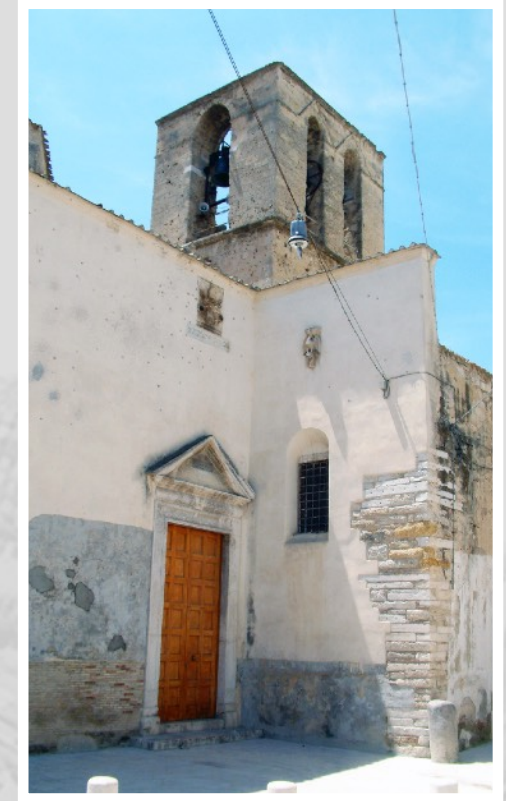
la facciata e il campanile (foto V. Russo)
