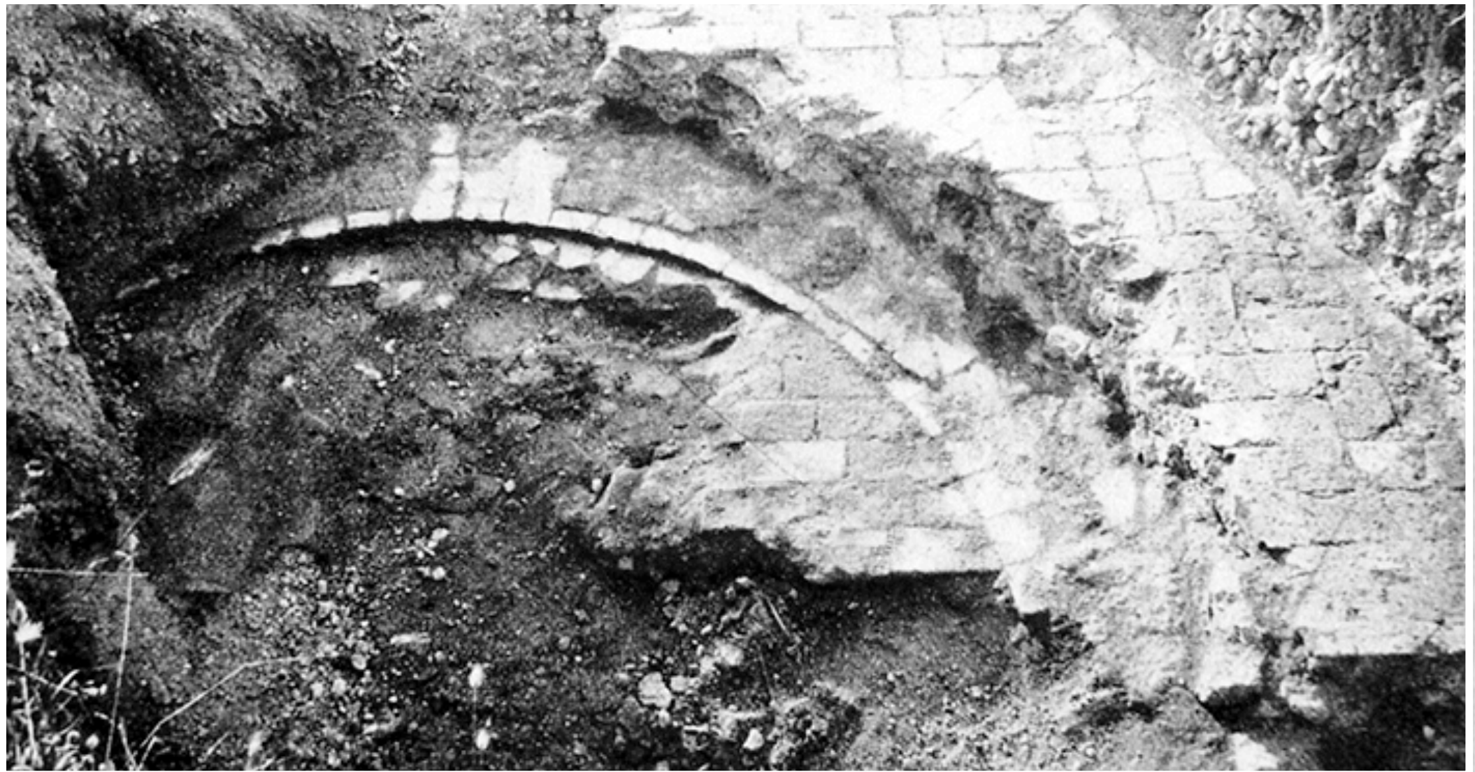
masseria Ciminarella: imbocco di un cunicolo su via Melfi (archivio L. Antonellis)
